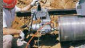
施工・工事部門
