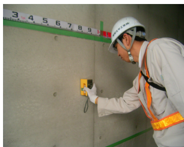
下地面の含水率確認
