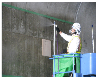
スプレー施工
