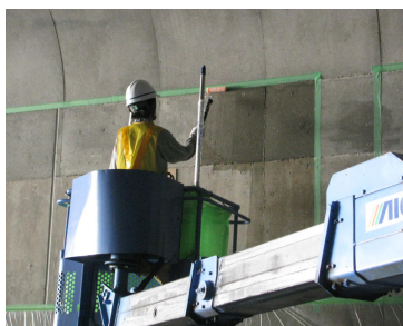
ローラー施工
